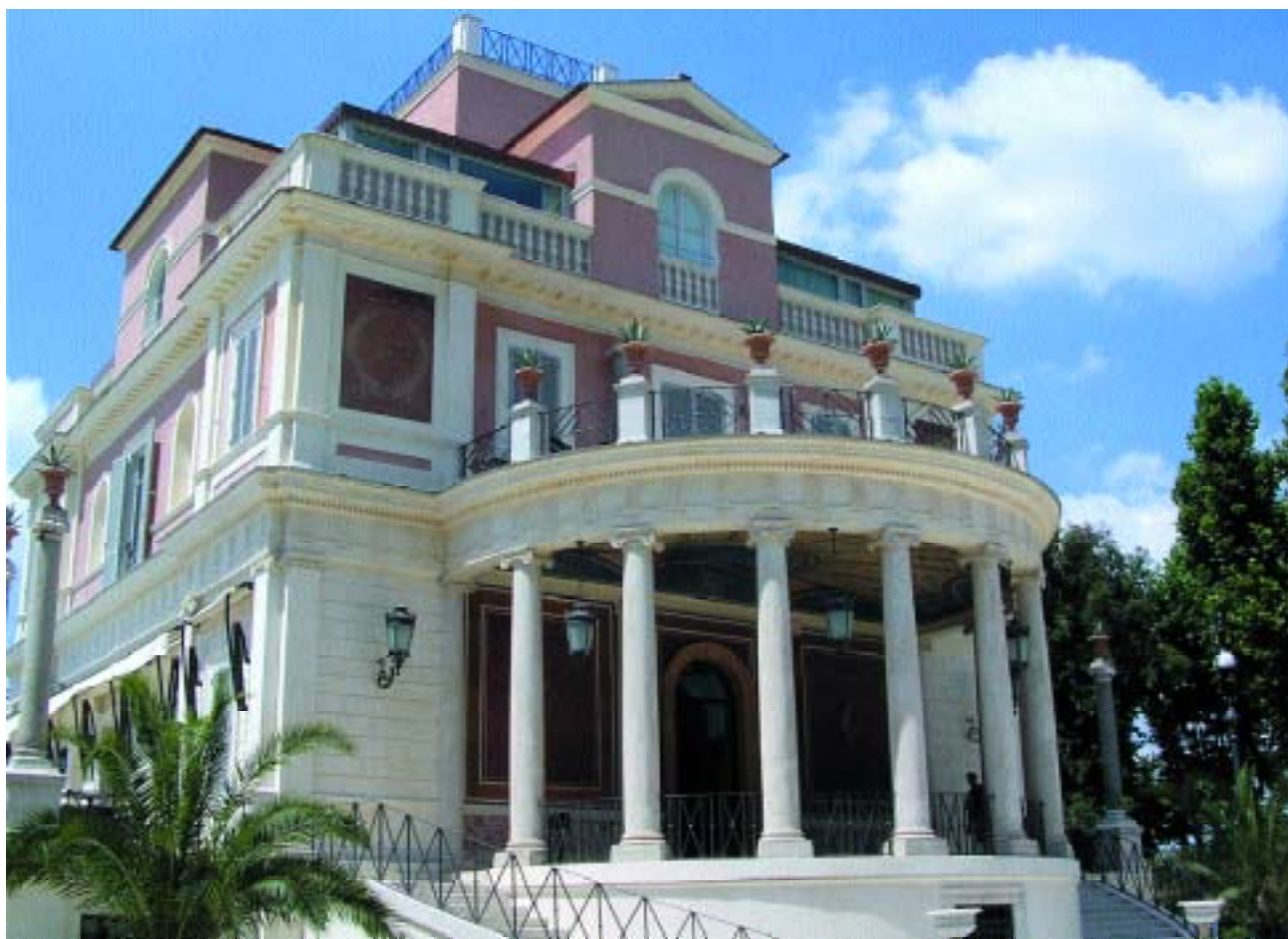
Facciata nord della Casina dopo i lavori
